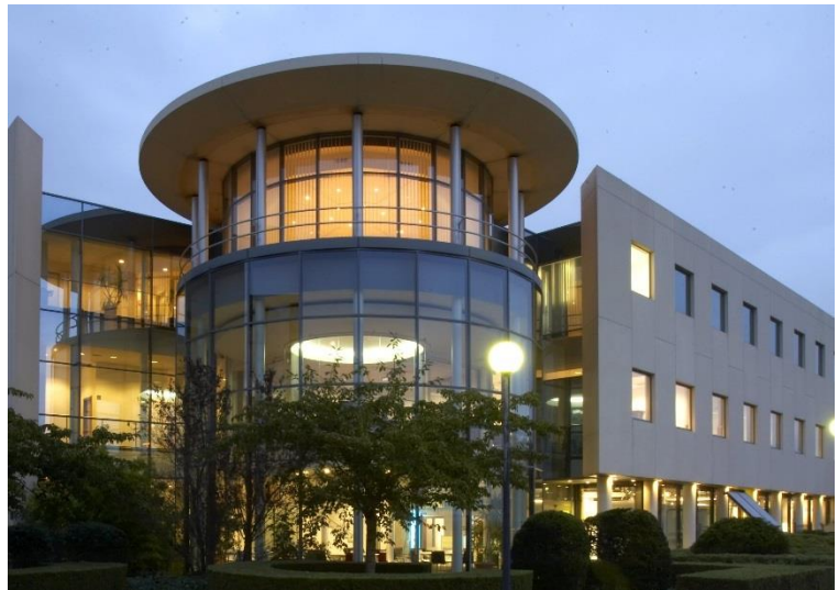
Siedziba firmy Daikin w Ostendzie
